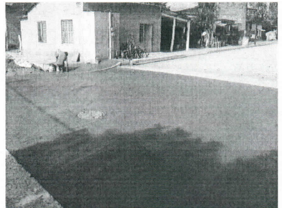
SUMINISTRO Y TENDIDO DE CONCRETO HIDRAULICO
