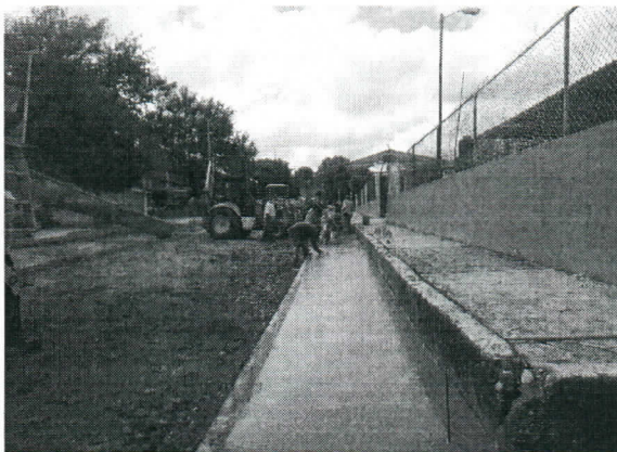
SUMINISTRO Y TENDIDO DE CONCRETO HIDRAULICO
