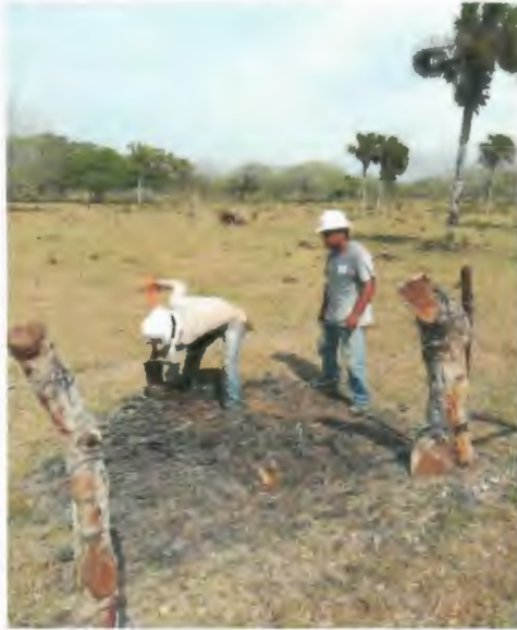
EXCAVACION MANUAL DE CEPA PARA RETENIDA EN TERRENO MIXTO.
