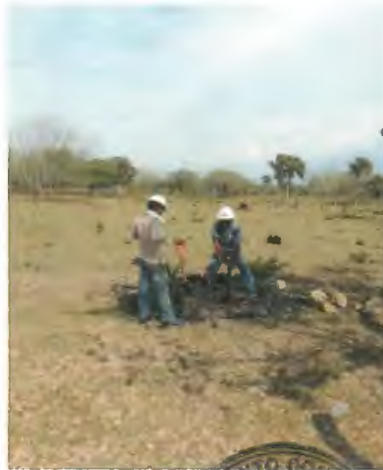
EXCAVACION MANUAL DE CEPA PARA POSTES DE CONCRETO EN TERRENO MIXTO.
