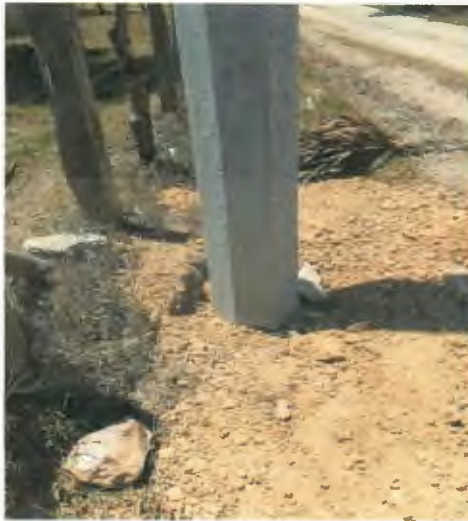
SUMINISTRO E INSTALACION DE POSTE DE CONCRETO DE 12750, INCLUYE RELLENO DE CEPAL CON PIEDRA CALIZA.
