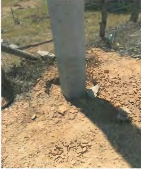
SUMINISTRO E INSTALACION DE POSTE DE CONCRETO DE 12750, INCLUYE RELLENO DE CEPA CON PIEDRA CALIZA.
