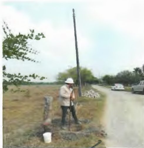
SUMINISTRO E INSTALACION DE POSTE DE CONCRETO DE 12750, INCLUYE RELLENO DE CEPAS CON PIEDRA CALIZA.
