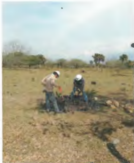
EXCAVACION MANUAL DE CEPA PARA RETENIDA EN TERRENO MIXTO.
