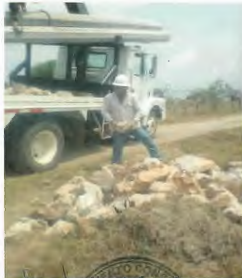
SUMINISTRO E INSTALACION DE POSTE DE CONCRETO DE 12750, INCLUYE RELLENO DE CEPA CON PIEDRA CALIZA
