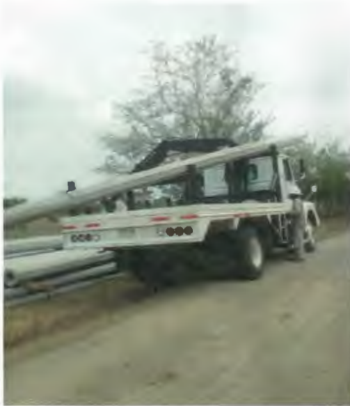
SUMINISTRO E INSTALACION DE POSTE DE CONCRETO DE 12750, INCLUYE RELLENO DE CEPA CON PIEDRA CALIZA
