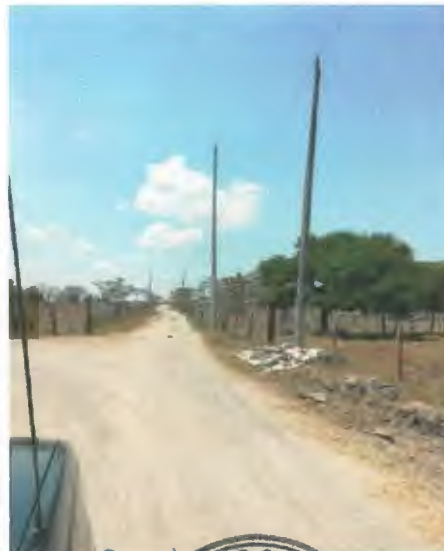
SUMINISTRO E INSTALACION DE POSTE DE CONCRETO DE 12750, INCLUYE RELLENO DE CEPAS CON PIEDRA CALIZA.
