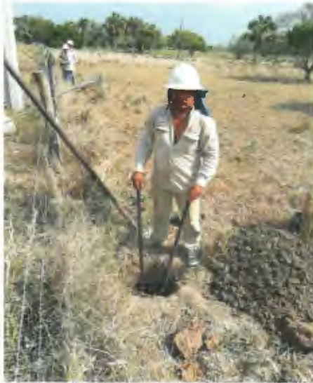
EXCAVACION MANUAL DE CEPA PARA POSTES DE CONCRETO EN TERRENO MIXTO.
