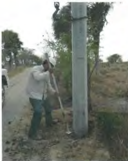
SUMINISTRO E INSTALACION DE POSTE DE CONCRETO DE 12750, INCLUYE RELLENO DE CEPAS CON PIEDRA CALIZA.
