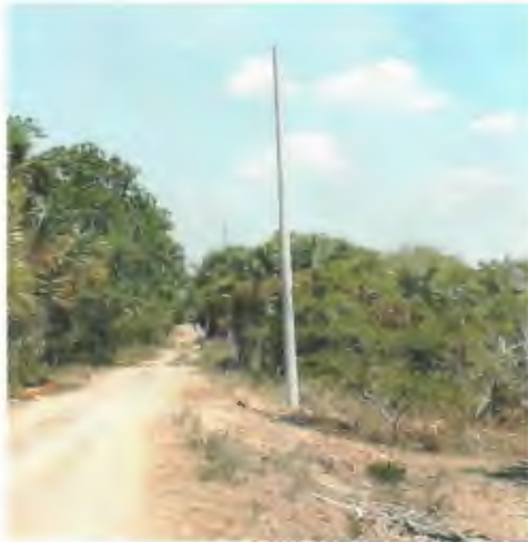
SUMINISTRO E INSTALACION DE POSTE DE CONCRETO DE 12750, INCLUYE RELLENO DE CEPA CON PIEDRA CALIZA.
