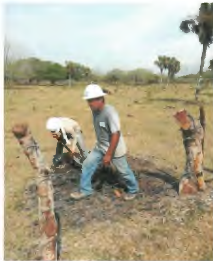
EXCAVACION MANUAL DE CEPA PARA POSTES DE CONCRETO EN TERRENO MIXTO.
