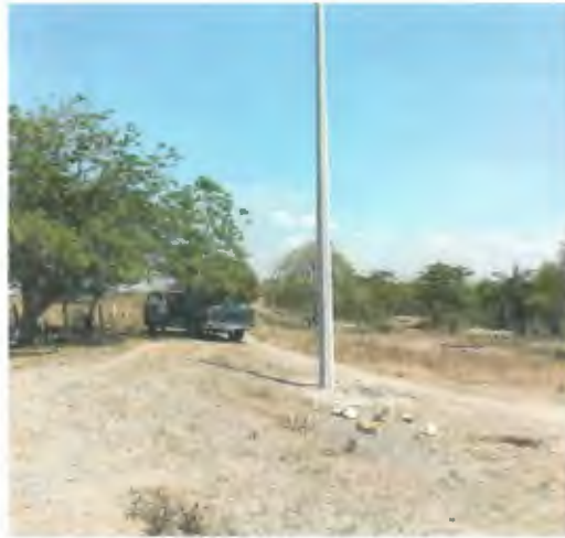
SUMINISTRO E INSTALACION DE POSTE DE CONCRETO DE 12750, INCLUYE RELLENO DE CEPA CON PIEDRA CALIZA.
