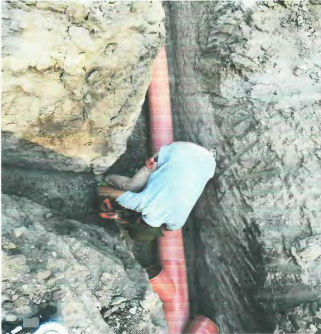
SUMINISTRO Y COLOCACION DE DE TUBO DE PVC ALCANTARILLADO SERIE 25 DE 200mm (8") DE DIAMETRO , SANITARIO
