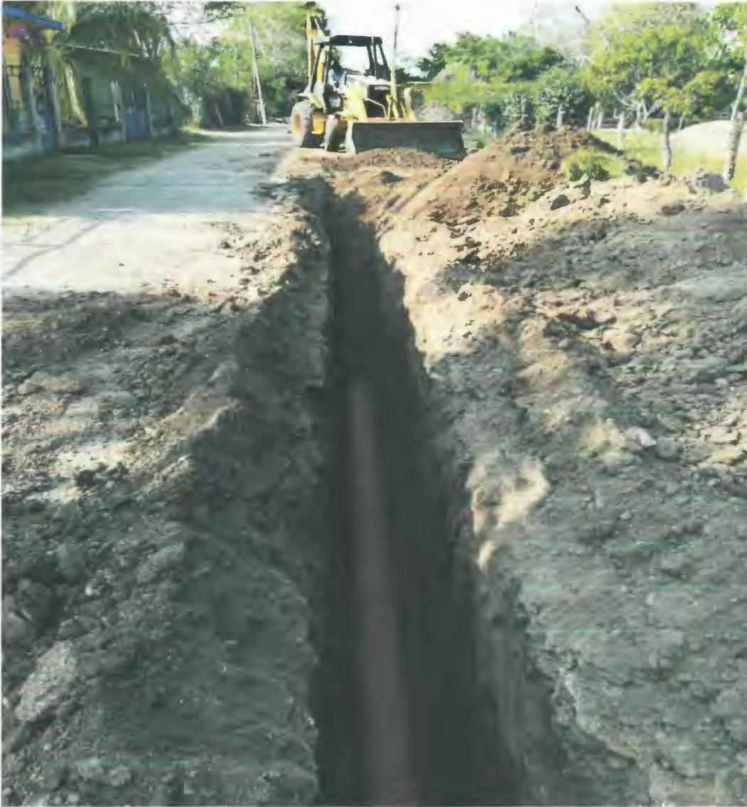
SUMINISTRO Y COLOCACION DE DE TUBO DE PVC ALCANTARILLADO SERIE 25 DE 200mm (8") DE DIAMETRO , SANITARIO
