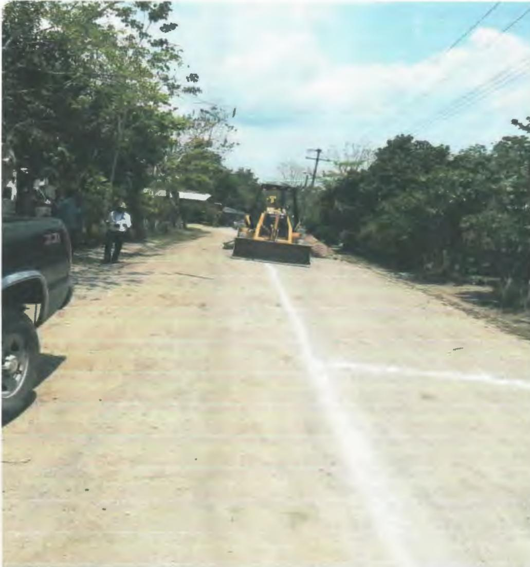
TRAZO Y NIVELACION TOPOGRAFICA DE TERRENO PARA IDENTIFICAR TRAYECTORIA DE CEPA PARA TUBERIA.
