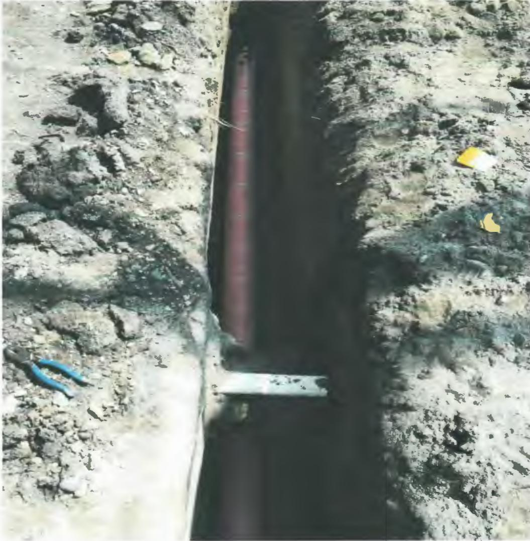
SUMINISTRO Y COLOCACION DE DE TUBO DE PVC ALCANTARILLADO SERIE 25 DE 200mm (8") DE DIAMETRO , SANITARIO
