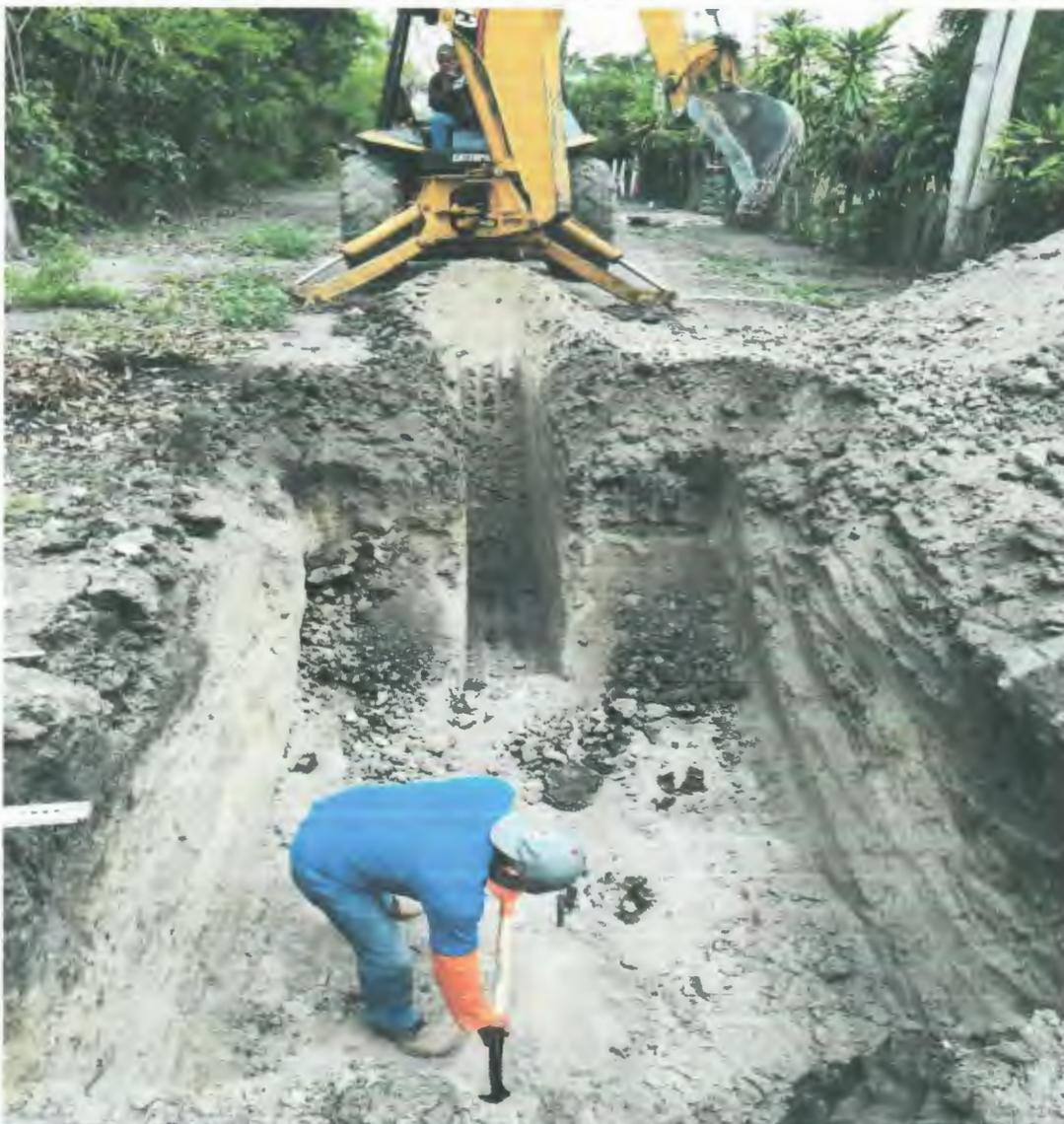
EXCAVACION EN ZANJA, CON RETROEXCAVADORA EN MATERIAL TIPO II, DE 0.00 A 4.00 M. DE PROFUNDIDAD
