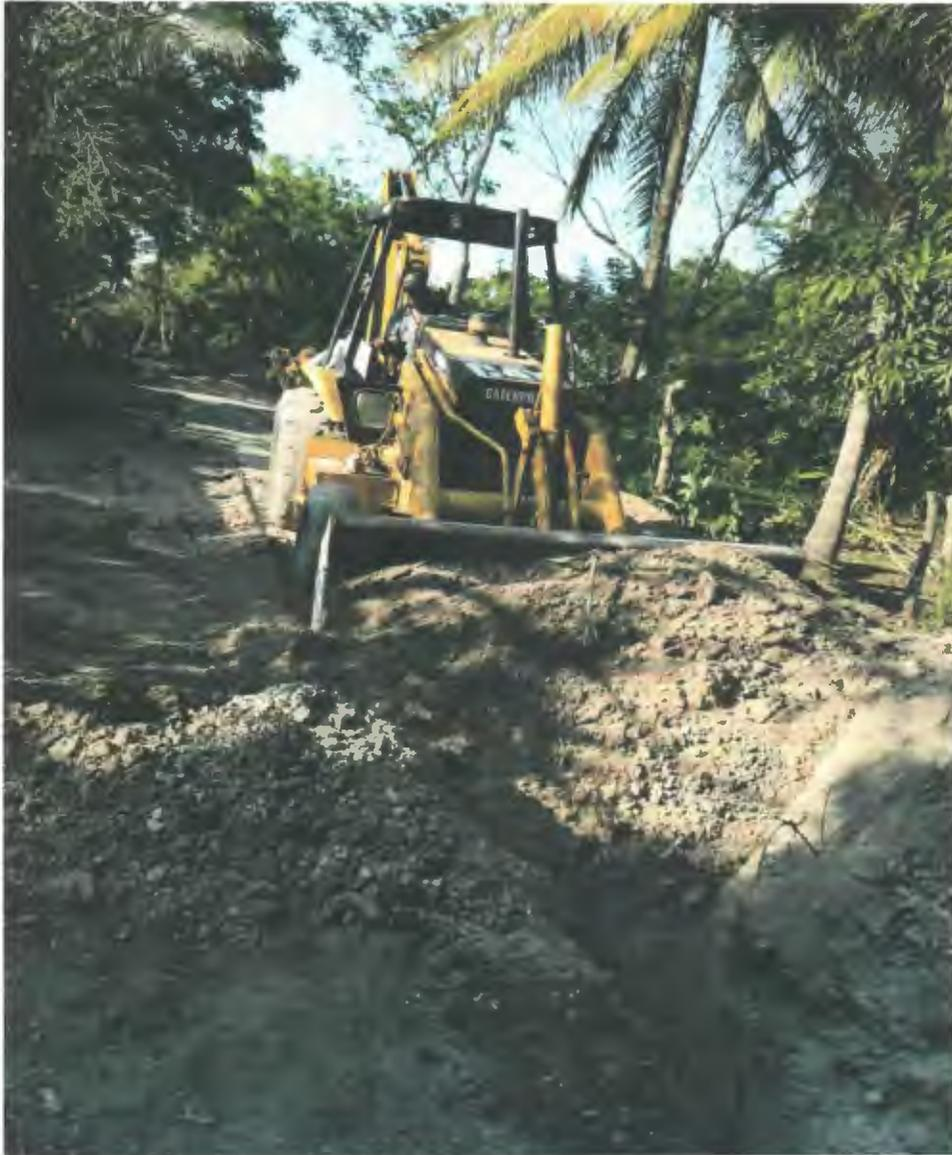
RELLENO DE ZANJA CON MATERIAL APROVECHABLE PRODUCTO DE LA EXCAVACION
