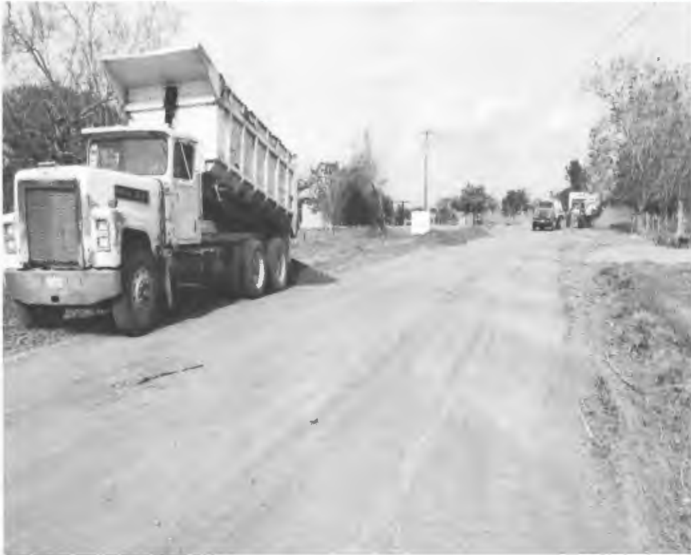
ACARREO EN CAMION KILOMETRO SUBSECUENTE DE MATERIAL MIXTO EN CAMINO LOMERIO SUAVE, BRECHA, TERRACERIA PRONUNCIADA, MONTAÑOSO.
