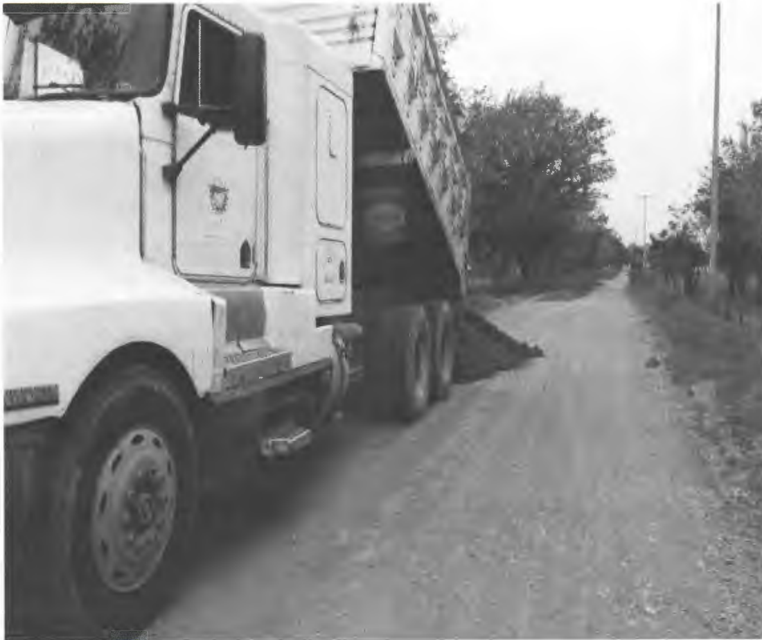
ACARREO EN CAMION 1 er. KILOMETRO DE MATERIAL MIXTO EN CAMINO LOMERIO, SUAVE, BRECHA, TERRACERIA PRONUINCIADA, MONTAÑOSO REVESTIDO. INCLUYE: CARGA CON EQUIPO MECANICO.
