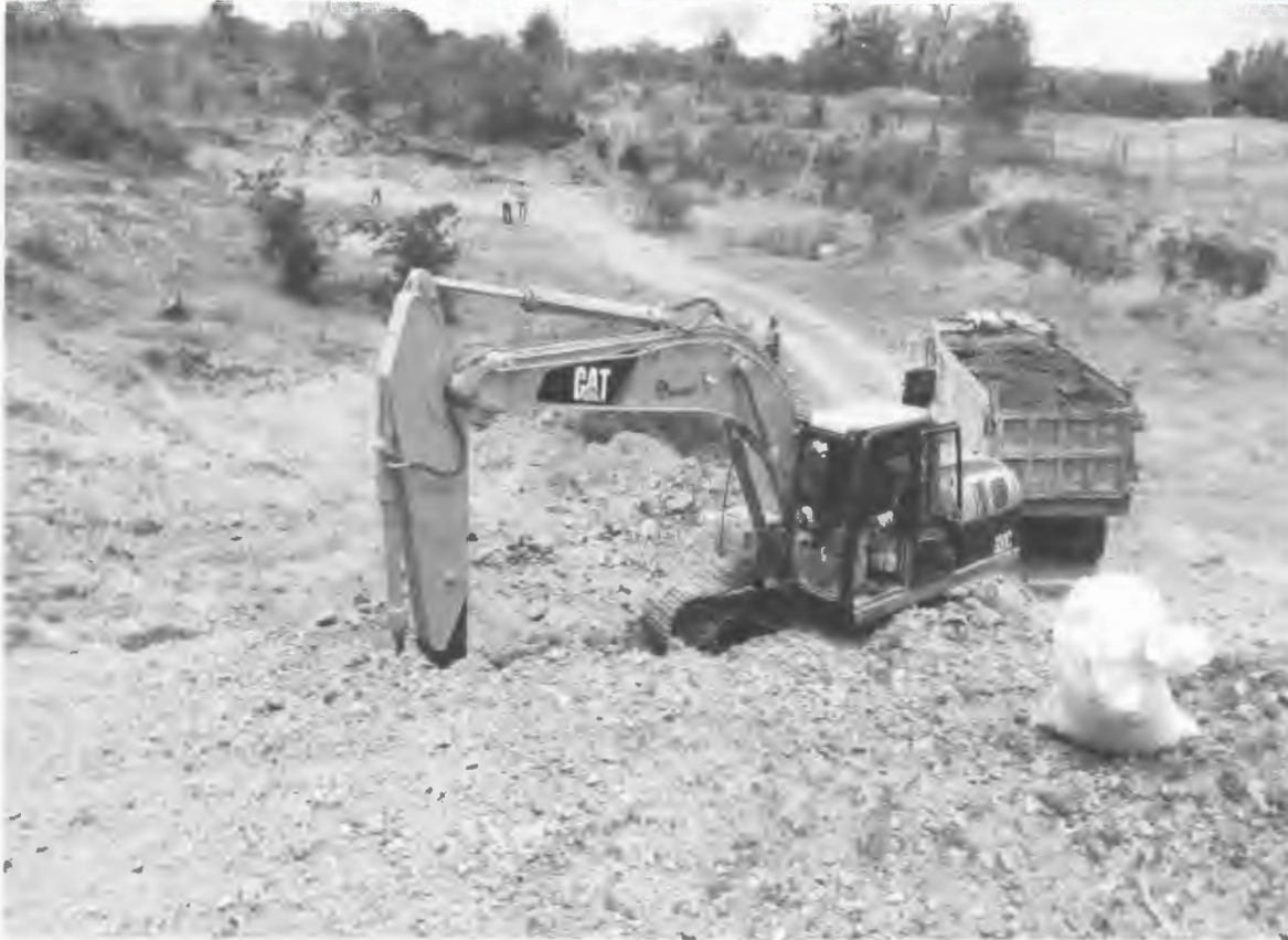
EXTRACCION DE MATERIAL DE BANCO (REVESTIMIENTO CEMENTANTE). INCLUYE: DESMONTE, EXCAVACION CON EQUIPO MECANICO Y PAGO DE REGALIAS.
