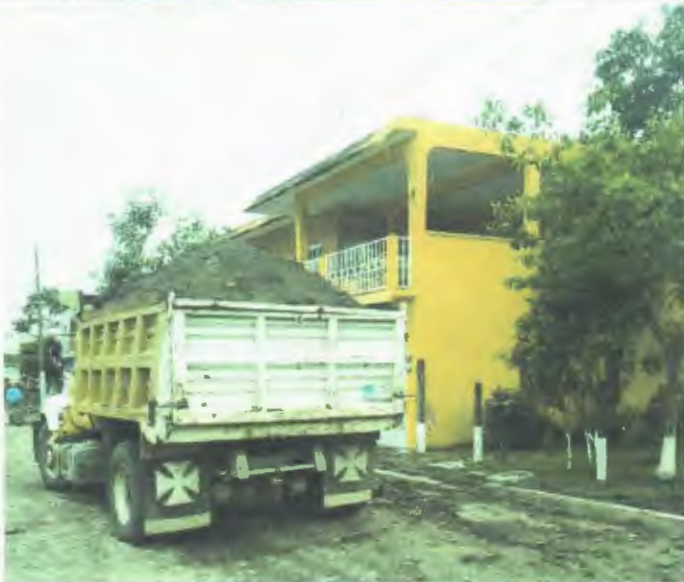
CARGA Y ACARREO AL 1ER., KILOMETRO DELM ATERIAL PRODUCTO DE LOS CORTES ✓
