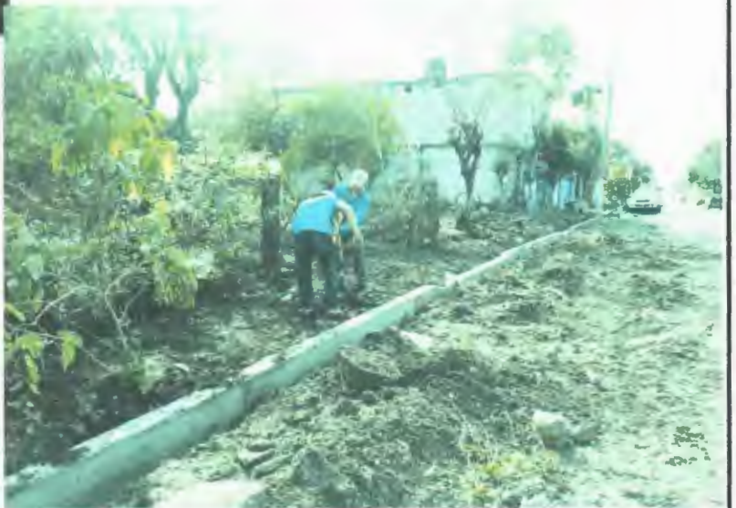
EXCAVACION A MANO EN MATERIAL TIPO II SECO
