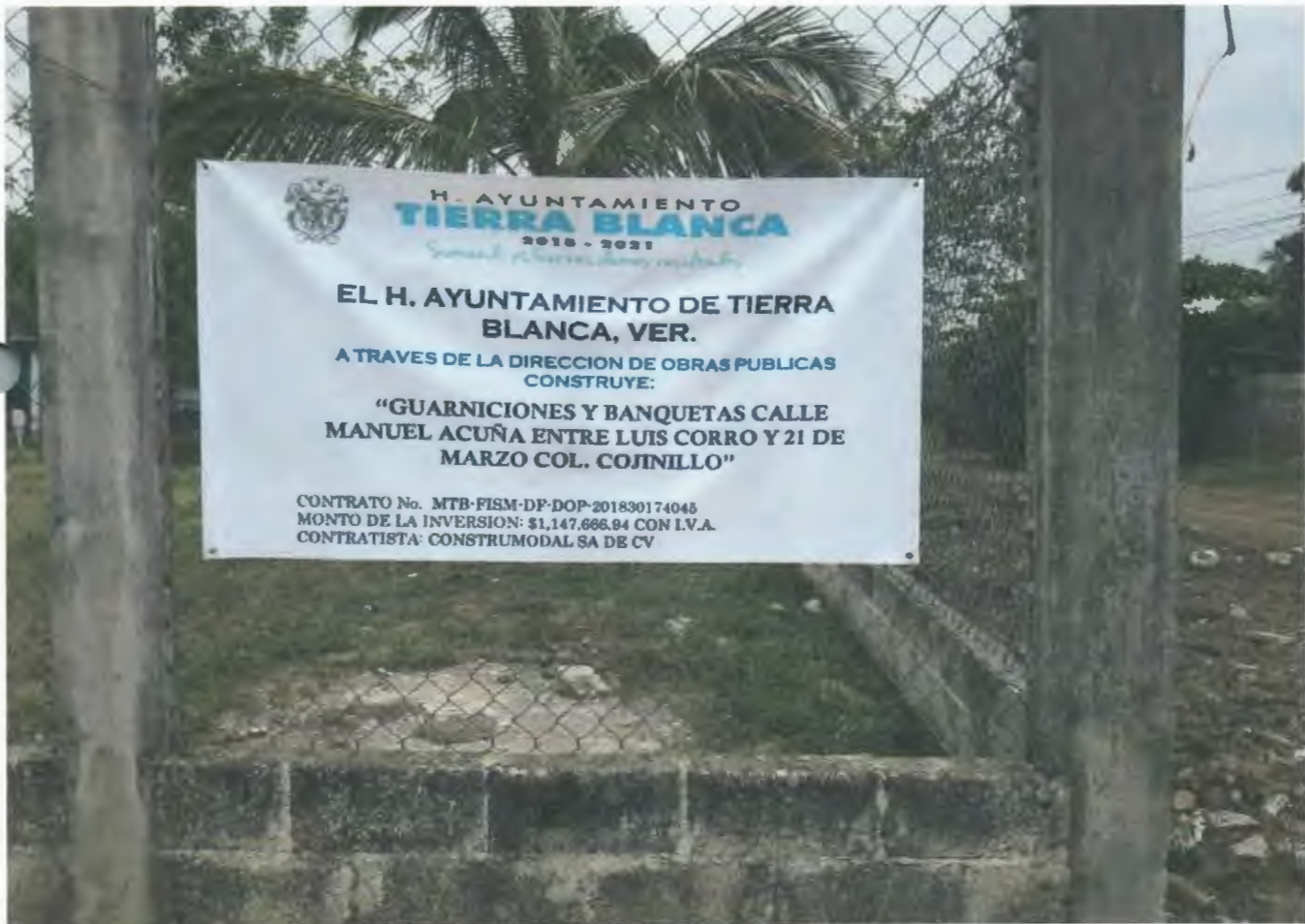
LETRERO DE OBRA HORIZONTAL, DE 0.87 x 1.45 MTS., CON INFORMACION SOBRE LA OBRA
