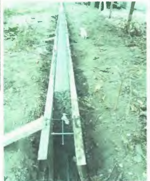
ELABORACION DE GUARNICION TRAPEZOIDAL DE CONCRETO HECHO EN OBRA F'C=150 KG/CM2., DE 15X20X40 CMS
