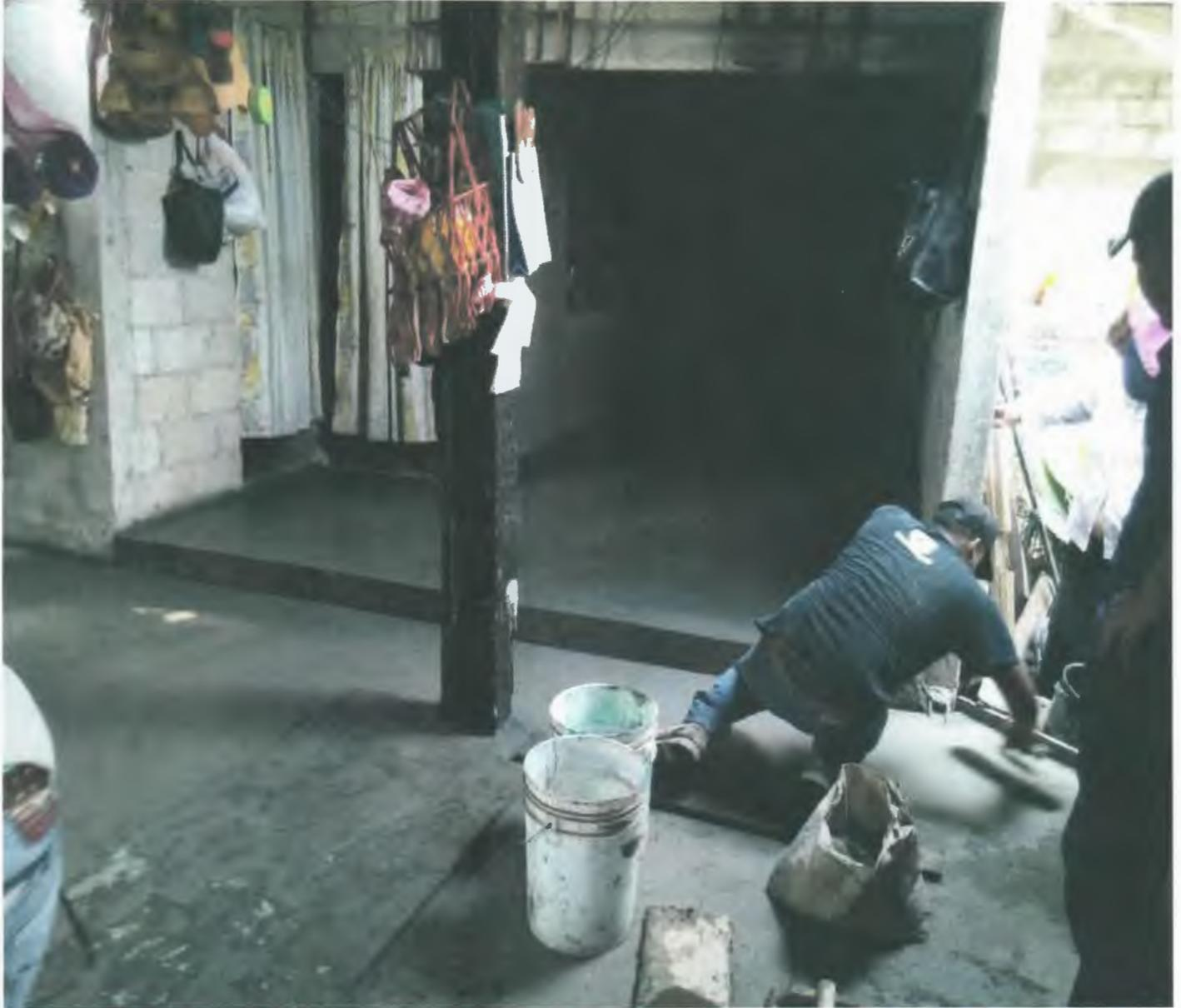
COLADO DE PISO DE 8 CM. DE ESPESOR DE CONCRETO HECHO EN OBRA F'C=150 KG/CM2, AGREGADO MAXIMO 3/4", ACABADO SEMIPULIDO
