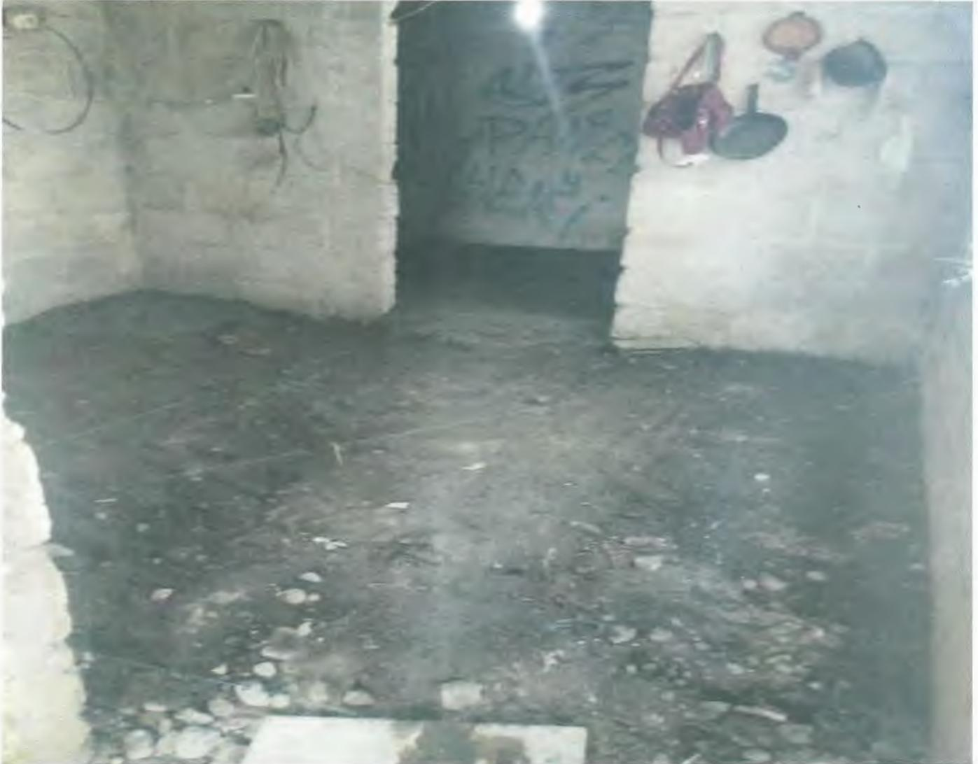
RELLENO COMPACTADO CON PISON DE MANO EN CAPAS DE 20CM. UTILIZANDO MATERIAL DE BANCO
