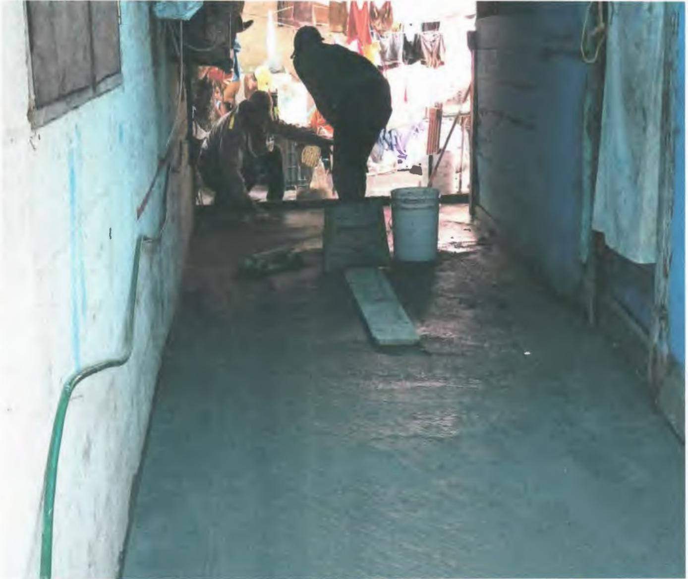
COLADO DE PISO DE 8 CM. DE ESPESOR DE CONCRETO HECHO EN OBRA F'C=150 KG/CM<sup>2</sup>, AGREGADO MAXIMO 3/4", ACABADO SEMIPULIDO
