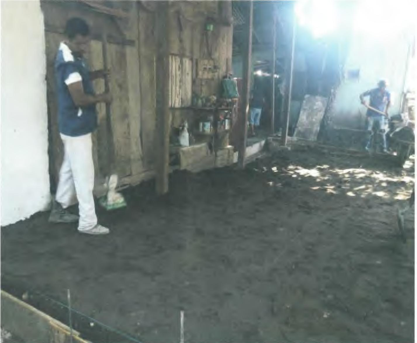
TRAZO Y NIVELACIÓN DE TERRENO PLANO POR MEDIOS MANUALES , RELLENO COMPACTADO CON PISON DE MANO EN CAPAS DE 20CM. UTILIZANDO MATERIAL DE BANCO
