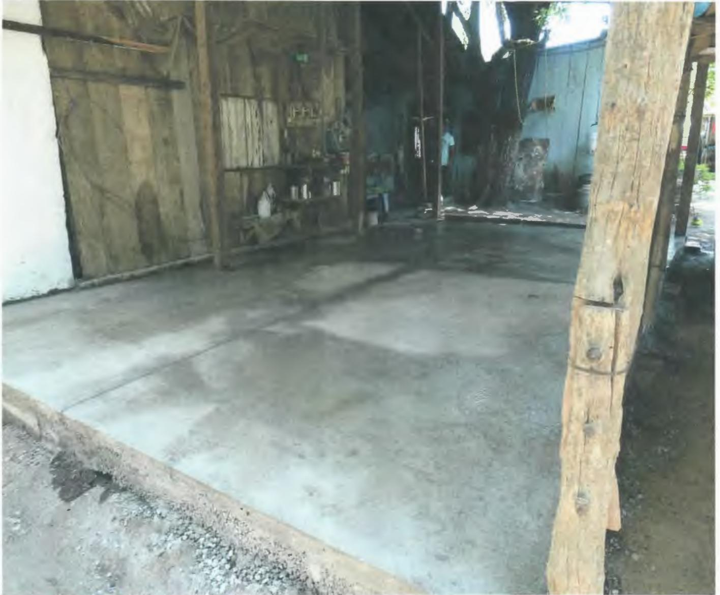
COLADO DE PISO DE 8 CM. DE ESPESOR DE CONCRETO HECHO EN OBRA F<sup>c</sup>=150 KG/CM<sup>2</sup>, AGREGADO MAXIMO 3/4", ACABADO SEMIPULIDO
